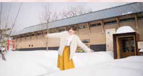
震災にも耐えた、大きな酒蔵を改築。第33回福島県建築文化賞正賞受賞。
